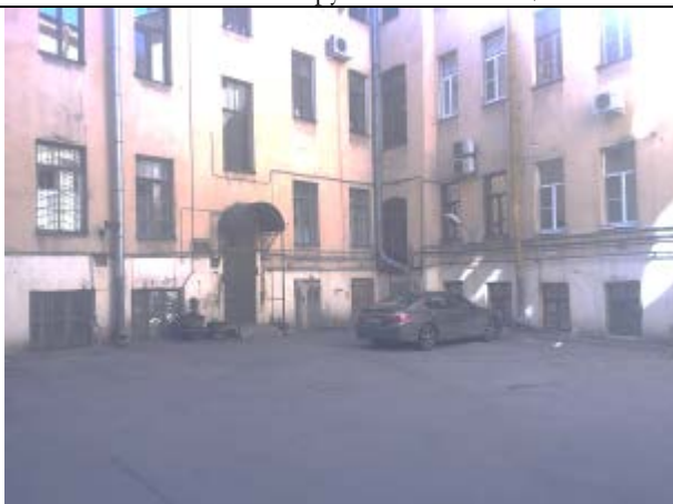
Фото 11. Внутри дворовая территория здания расположения Объекта оценки
