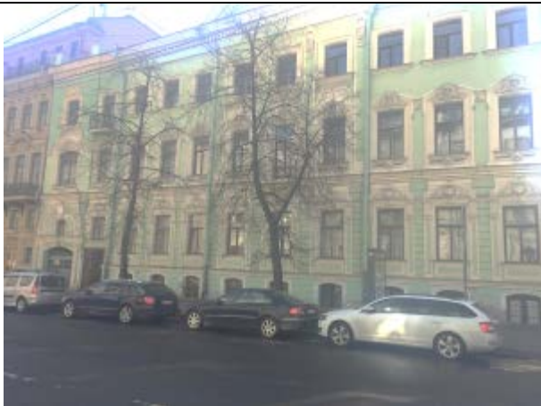
Фото 7. Вид здания расположения Объекта оценки
