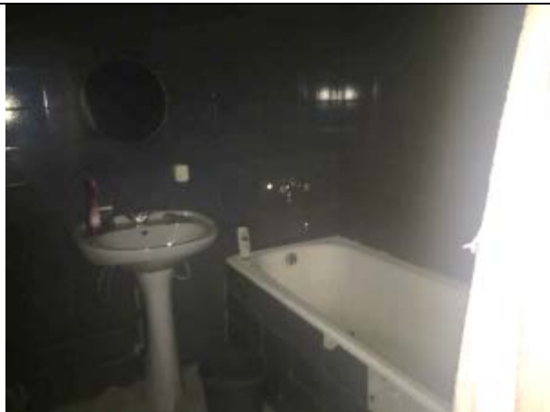
Фото 22. Типичное состояние Объекта оценки
